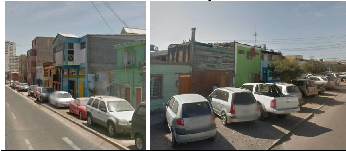
Ilustración 7.5-5 Estacionamientos irregulares en aceras
