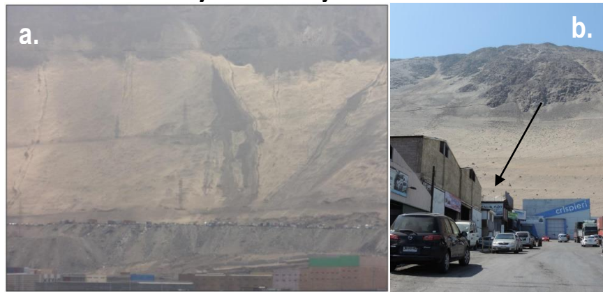
Fuente: a) Extraído de SERNAGEOMIN (2013); b) Archivo fotográfico de terreno. La flecha negra señala la dirección de caída de rocas
