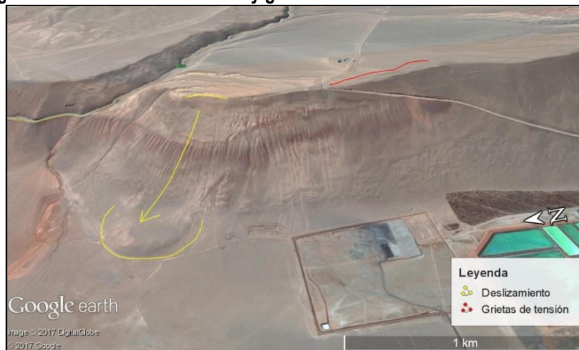
Figura 6-7: Deslizamiento de roca y grietas de tensión en el Acantilado Costero.
