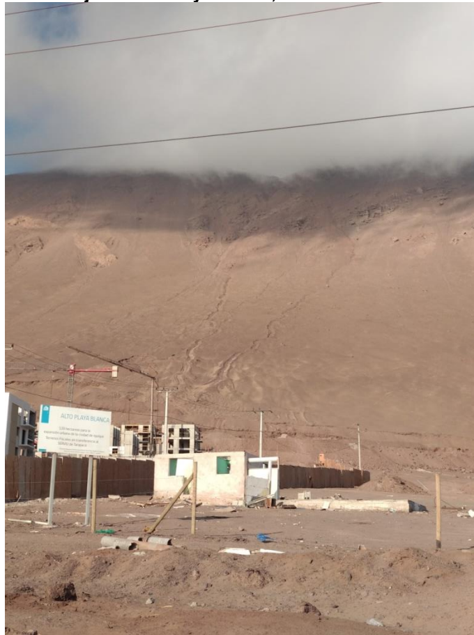
Figura 6-3: Conjunto Alto Playa Blanca, ubicado en un abanico aluvial.
