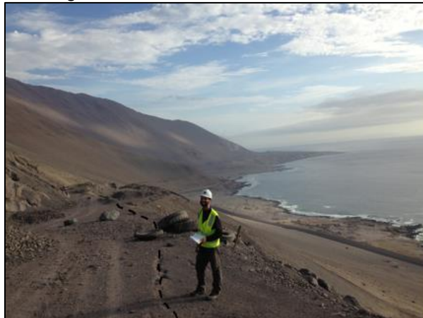
Figura 11-21: Fotografía de grieta de tensión en sector de descarte de Depósitos Antrópicos.
