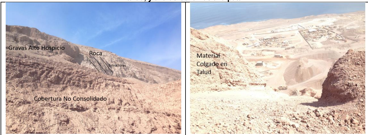
Figura 11-12: Fotografía tomada desde banco superior de la cantera. A la izquierda hacia la cresta del talud, y a la derecha hacia la pata.
